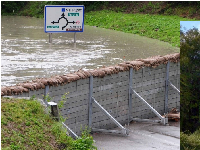
Quelle: http://hitoiro.info/sandsacke-fur-hochwasserschutz-or92/ , abgerufen im April 2018
